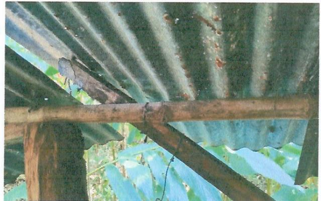
Foto 4: VIGAS EN MAL ESTADO
