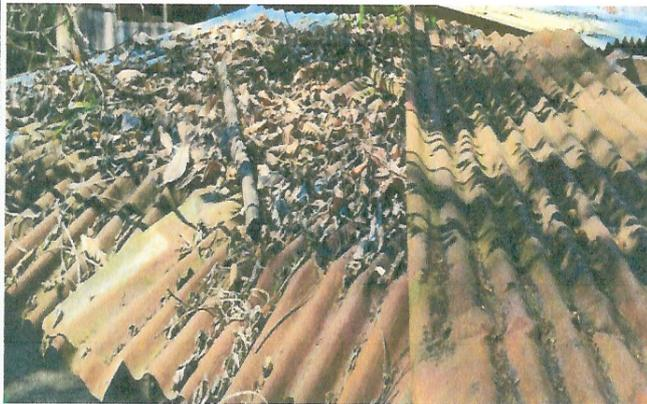
Foto 3: TECHO DETERIORADO
